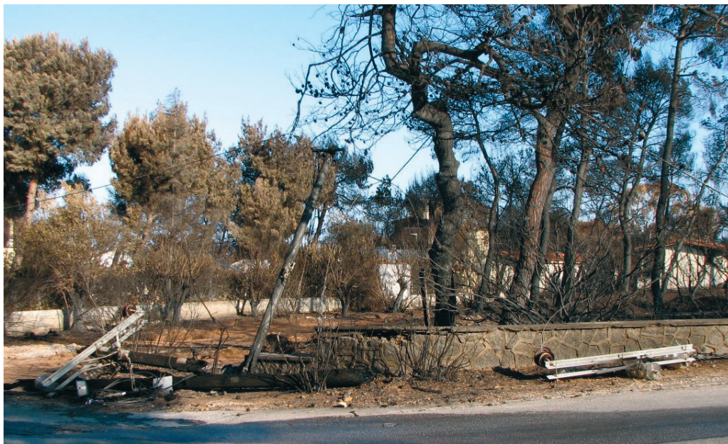
Изображение 4 : Част от електрическата мрежа разрушена от горски пожар
